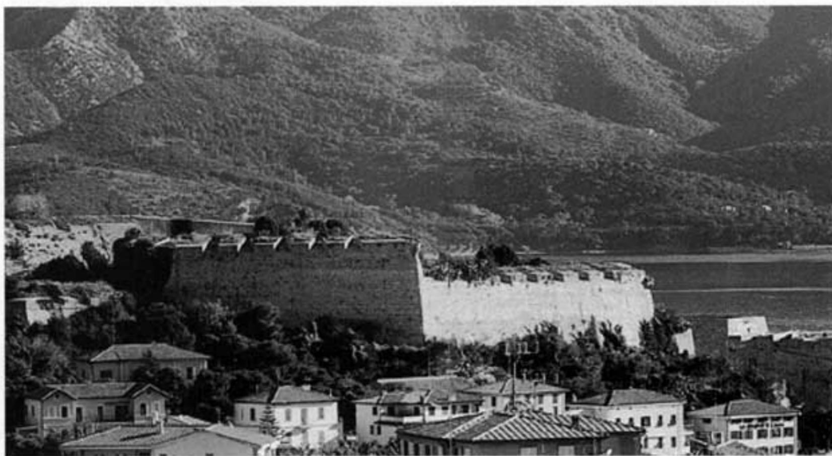
Il Bastione delle Palle. La diversa illuminazione delle muraglie evidenzia il balzo in altezza tra il settore delle Palle di Sotto e quello delle Palle di Sopra.
